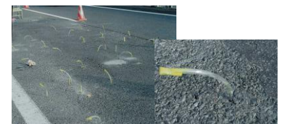
⑧注入完了
