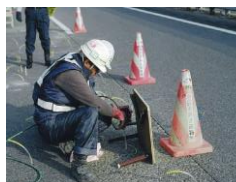
⑦注入状況
