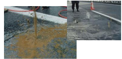
④床版洗浄(左: 泥水流出、右: 清水流出)
