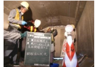
【橋梁下面からの施工】
