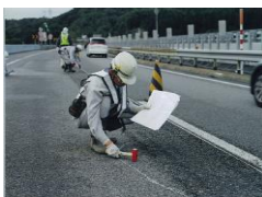
①浮き調査(舗装面)
