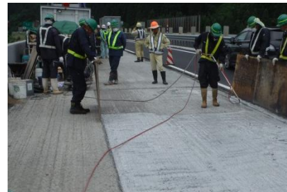
AT448 吹付け状況
