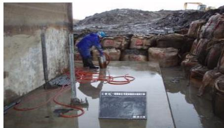
アルファテック340は、水中接着性能の高い低粘度なエポキシ接着剤です。乾燥面の接着はもとより濡れたコンクリートと鋼材双方の高い接着性能と、低粘度で可使時間が長く施工性に優れることから、気中および水中コンクリート構造物のひび割れ注入補修、コンクリート連続繊維シート補強・防水工・保護工のプライマー、新旧コンクリートの打ち継ぎ面接着など様々な用途に優れた機能を発揮します。
