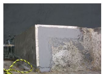
グラウト完了
