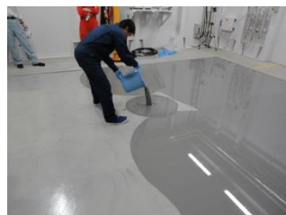
アルファテック 150 打設
