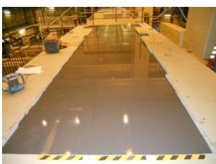
アルファテック 150 打設後
