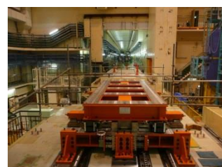
移動架台の設置
