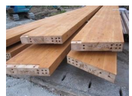
鉄筋挿入孔
