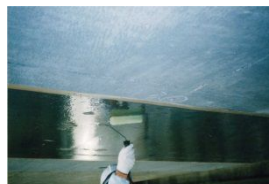
プライマー工 (②)
