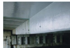
仕上げ工 (⑦)
