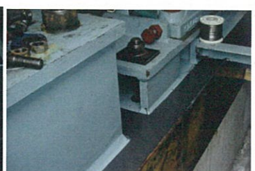
エポキシグラウト打設完了(反駆動側)
