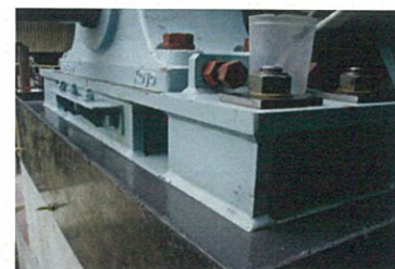
エポキシグラウト打設完了(反駆動側)
