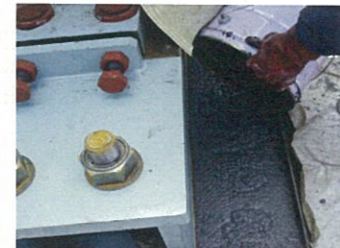
エポキシグラウト打設(アルファテック800)
