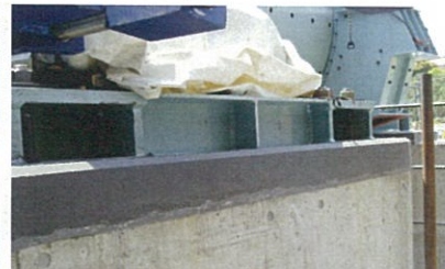
エポキシグラウト打設完了(反駆動側)
