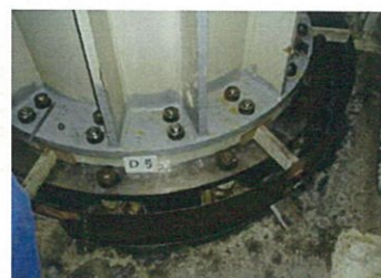
外側型枠の設置完了
