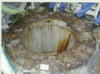
ベース撤去の状況1
