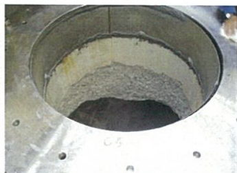
内側型枠の設置完了
