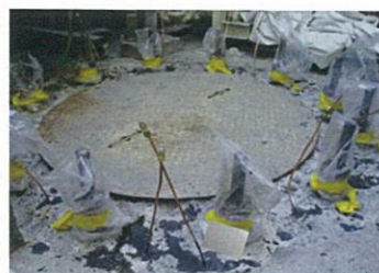
注入鋼管・シールの設置完了
