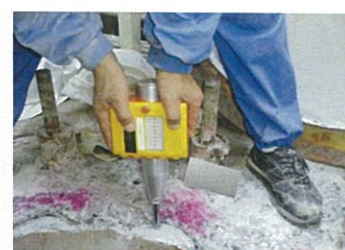
圧縮強度調査
