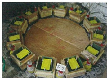
パッカー用型枠設置・シール完了
