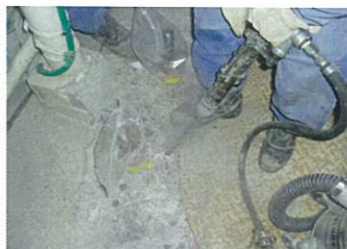
樹脂注入孔の穿孔
