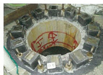
パッカー設置完了
