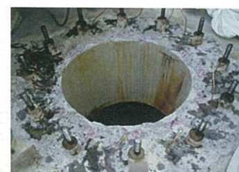
樹脂注入の完了
