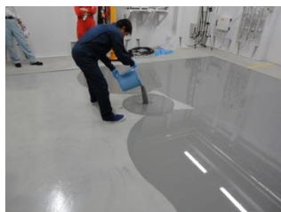
アルファテック 150 打設
