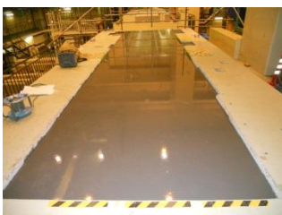
アルファテック 150 打設後
