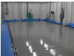
下地処理の上 AT340 塗布後 AT830H 打設
