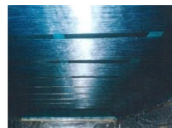
連続繊維シート貼付け工 (⑤)
