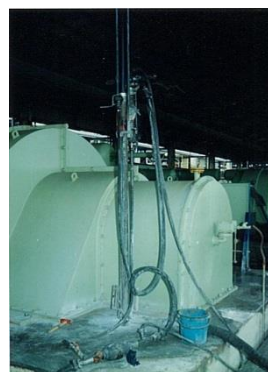
φ50×L2800 注入孔削孔
