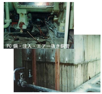
コンプレッサ基礎貫通亀裂と打継ぎよりアルファテック 370 流出
