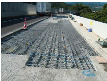
ウォータージェットはつり完了状況
