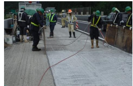
AT448 吹付け状況
