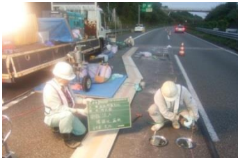
【舗装面からの施工】
