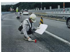
①浮き調査(舗装面)
