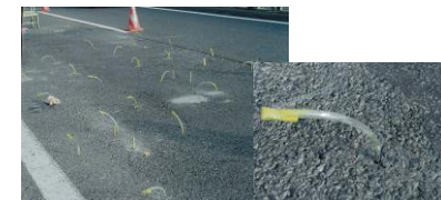
⑧注入完了
