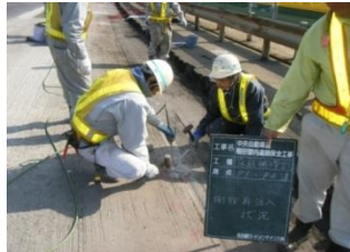
【切削面からの施工】
