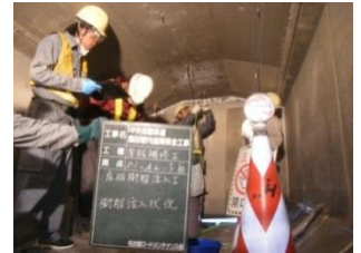
【橋梁下面からの施工】
