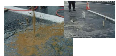
④床版洗浄(左: 泥水流出、右: 清水流出)
