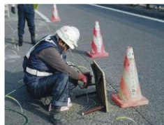
⑦注入状況
