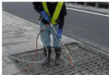
アルファテック448は、新旧コンクリートの打ち継ぎ用のエポキシ接着剤です。フレッシュコンクリートに対して、高い接着性能を発揮します。また、吹き付け塗布の施工性にも優れているので、道路橋のコンクリート床板の補修、増厚補強のための打ち継ぎ接着、コンクリート構造物のかさ上げなど、フレッシュコンクリートの打ち継ぎ接着に最適です。
