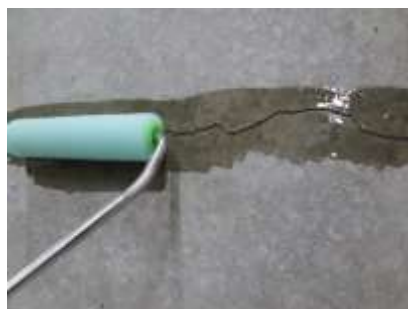
【塗布状況（鉛直面）】
