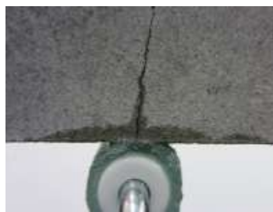
【浸透状況（上向き）】
