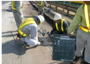
【切削面からの施工】
