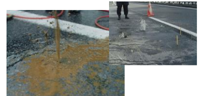
④床版洗浄(左：泥土水流出、右：清水流出)
