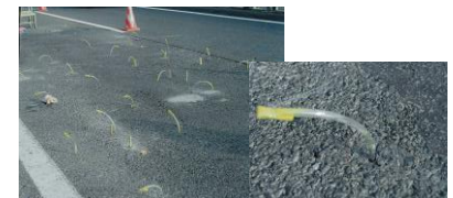
⑧注入完了
