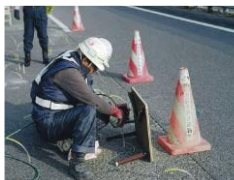
⑦注入状況
