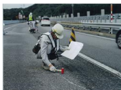
①浮き調査(舗装面)
