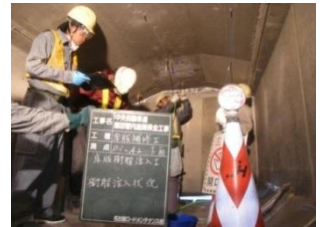
【橋梁下面からの施工】
