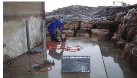
JWWA K 143 (水道用コンクリート水槽内面エポキシ樹脂塗料塗装方法) 適合品
