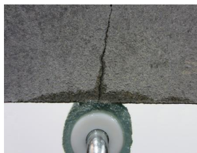
【浸透状況 (上向き)】
