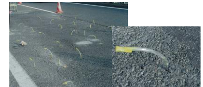
⑧注入完了
