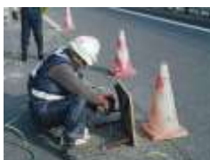
⑦注入状況
