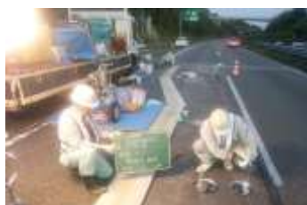
【舗装面からの施工】
