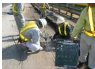
【切削面からの施工】
