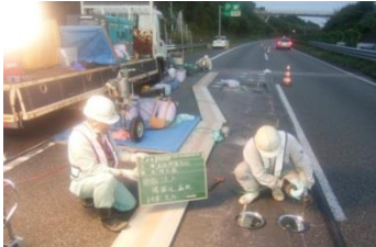
【舗装面からの施工】
