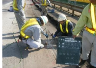
【切削面からの施工】
