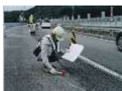
①浮き調査(舗装面)
