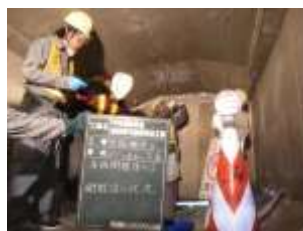
【橋梁下面からの施工】
