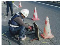
⑦注入状況
