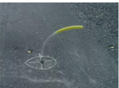
⑤注入プラグ取付
