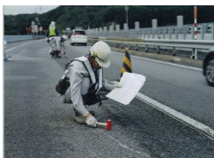
①浮き調査(舗装面)
