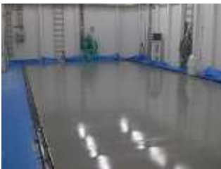
下地処理の上 AT340 塗布後 AT830 打設
