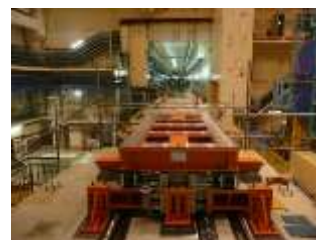
移動架台の設置
