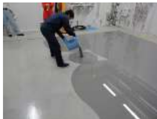
アルファテック 150 打設
