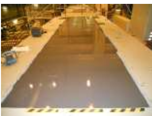
アルファテック 150 打設後
