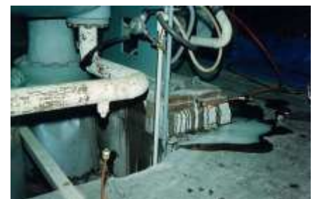
台板とグラウト内からアルファテック 300 連続流出
