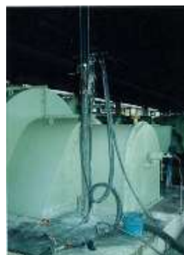
φ50×L280 注入孔削孔
