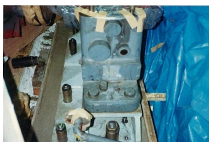
レベル調査後のエポキシグラウト (アルファテック 800) 充填
