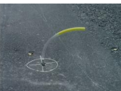
⑤注入プラグ取付
