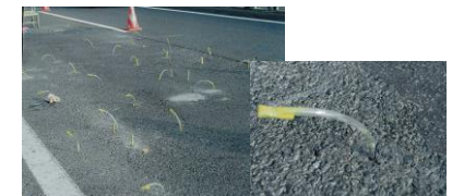
⑧注入完了
