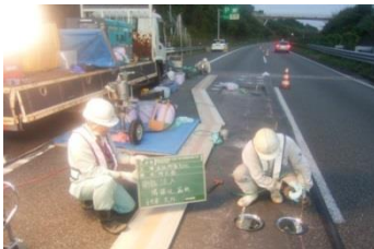
【舗装面からの施工】
