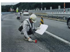
①浮き調査 (舗装面)
