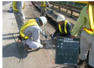
【切削面からの施工】
