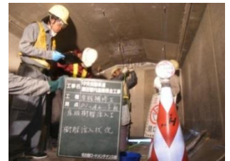
【橋梁下面からの施工】
