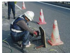
⑦注入状況
