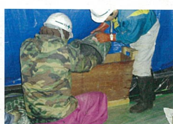
エポキシグラウトの打設
