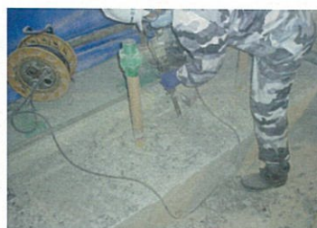
基礎表面のテッピング(20mm研り)
