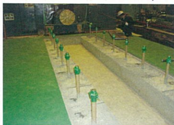
施工前の基礎全景
