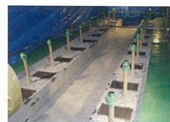
パッドの打設完了
