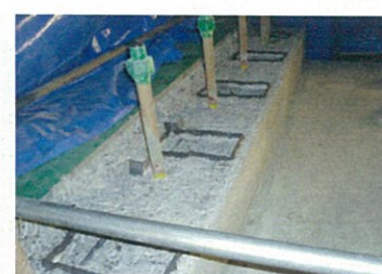
エポキシパテにてパッド用の堰を作製
