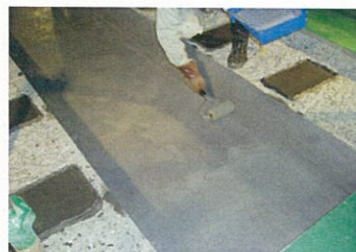
オイルパン下 防油塗装(アルファテック601)
