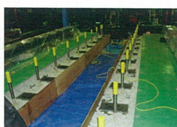
内側型枠の設置
