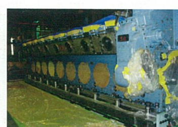
機関設置・芯出し完了
