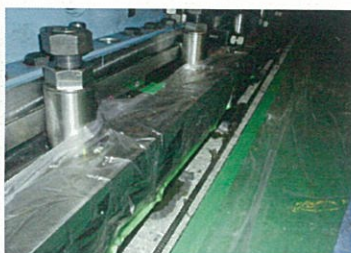
打設部の養生
