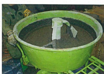
エポキシグラウトの混合(アルファテック800)
