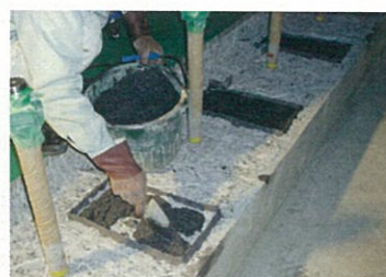
パッドの打設(アルファテック800)
