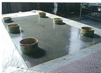
グラウト完了(アルファテック830)
