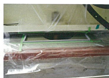
アンカー孔へ型枠設置
