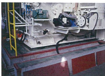
機械装置の設置完了
