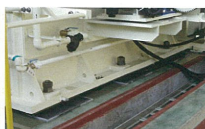
アンカーグラウト完了(アルファテック800)
