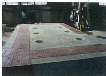
施工前の基礎状況
