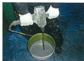
セルフレベリング材混合(アルファテック150)
