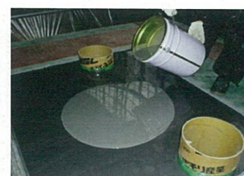
セルフレベリング材打設
