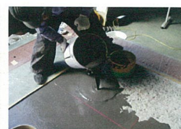
グラウト打設・厚み20mm(アルファテック830)
