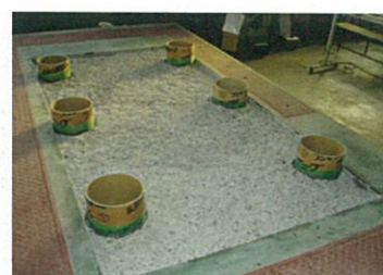
型枠設置・シール完了
