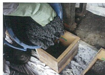
パッカーグラウトの打設(アルファテック800)
