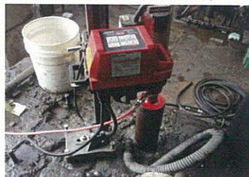
既設アンカーの撤去
