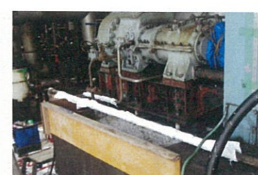
型枠設置・パテシール完了
