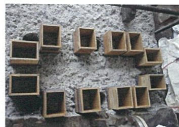
パッカー型枠の設置 (パテシール)
