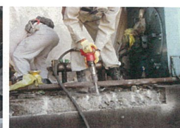
既設グラウトの研り
