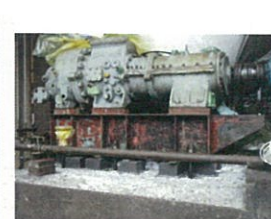
本体及びベース設置 (仮レベル完了)
