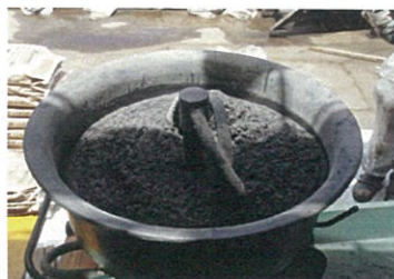
エポキシグラウト混合(アルファテック800)
