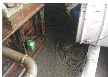
グラウト打設
