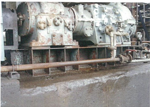
改修前の全景
