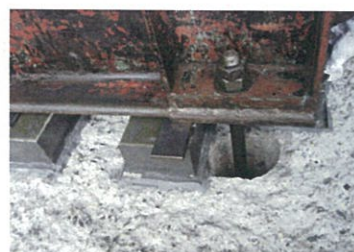
アンカーボルトの設置
