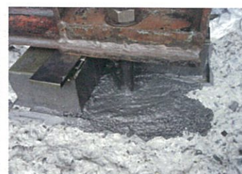
アンカーグラウト(アルファテック800)
