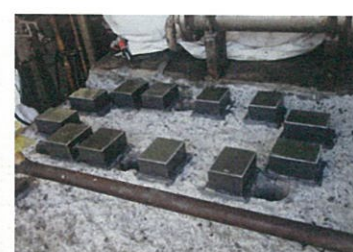
パッカーグラウト完成
