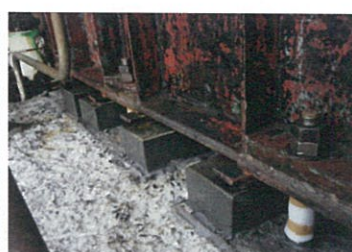
本芯出し調整完了
