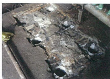
アンカー撤去の完了
