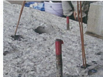
補強鉄筋・注入銅管のシール
