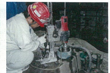
アンカーボルトの撤去
