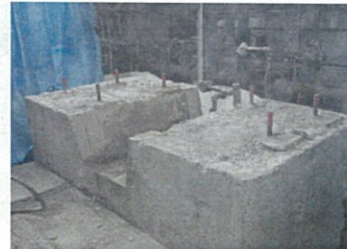
コンプレッサー側装置撤去状況
