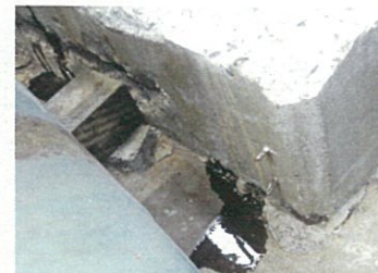
打継ぎよりエポキシ樹脂の流出2
