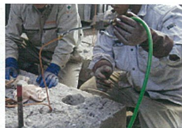
エポキシ樹脂の注入(アルファテック340)
