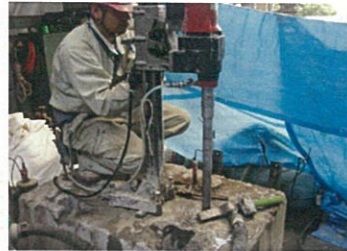
基礎打継ぎ注入孔の穿孔
