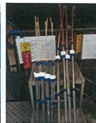
補強鉄筋・注入銅管
