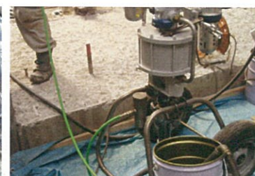
高圧注入ポンプでの圧送
