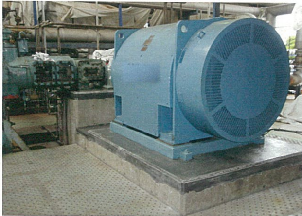
改修後の全景
