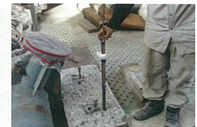
補強鉄筋・注入銅管の設置2
