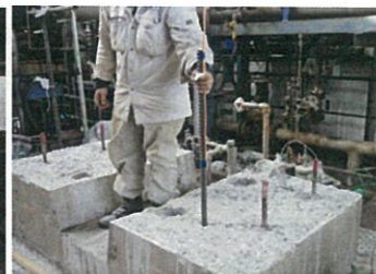
補強鉄筋・注入銅管の設置1
