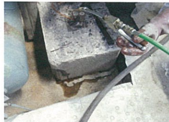
打継ぎよりエポキシ樹脂の流出1
