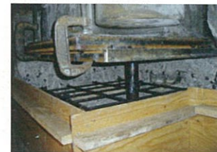
配筋・型枠の設置
