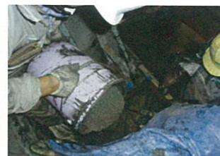
エポキシグラウト打設
