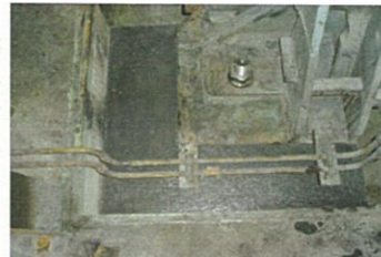
最終グラウト打設
