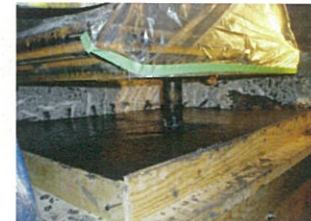
一段目・グラウト打設終了
