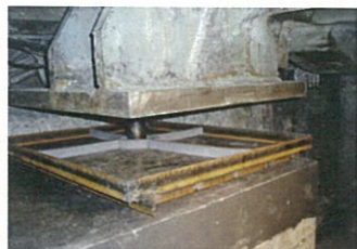
脚部とベースの間にチョック材を打設
